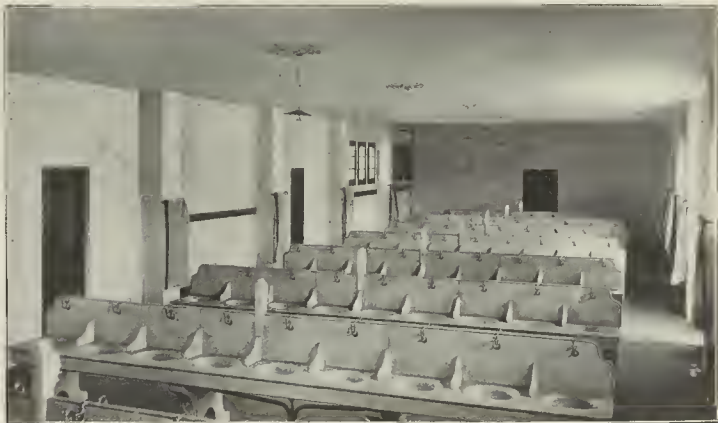
Lavabos del Pabellón de higiene para los obreros del puerto
